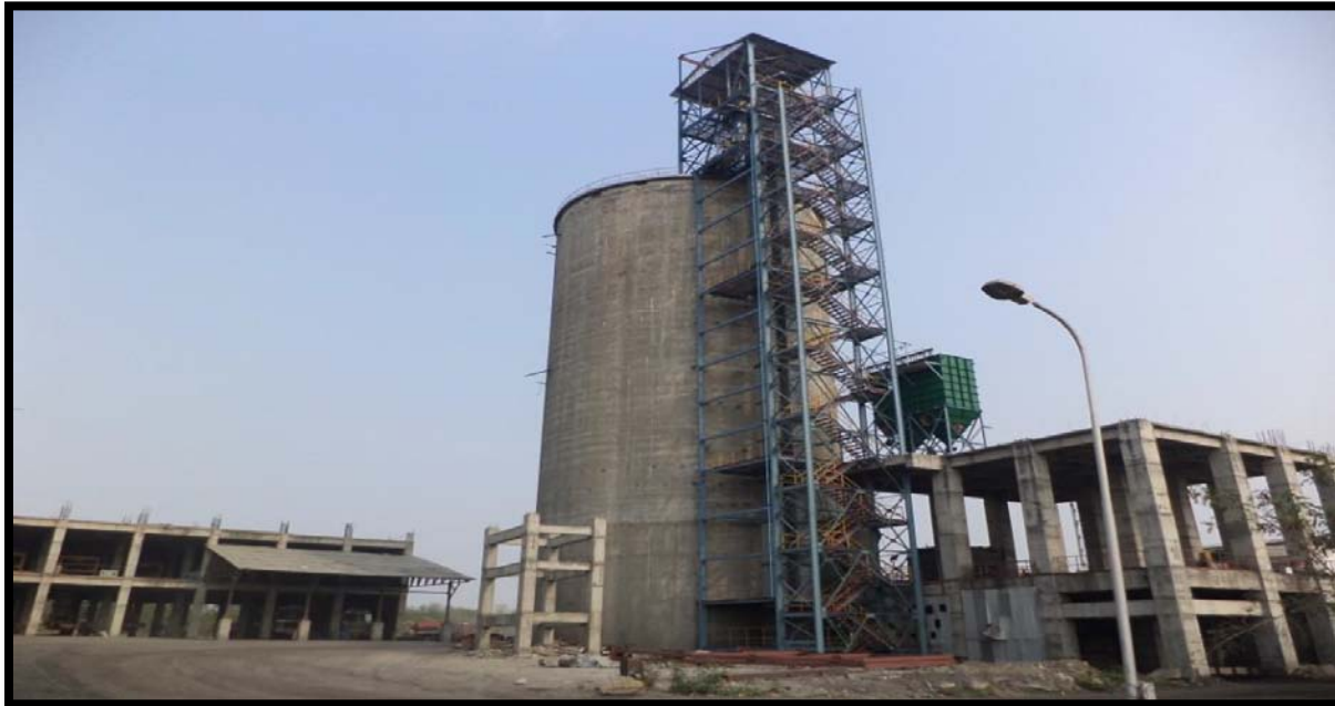
fly ash silo
